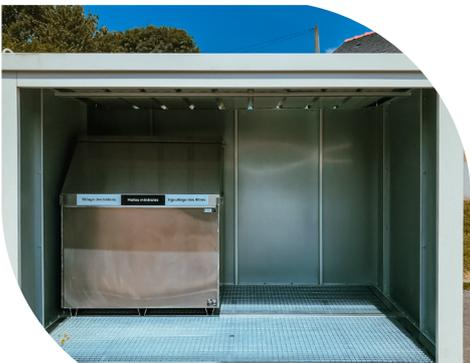
Cet abri, incluant **deux bacs de rétention**, permet de protéger la cuve à huiles.
